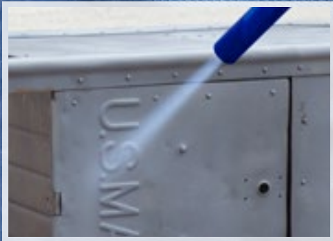
钢结构表面处理
